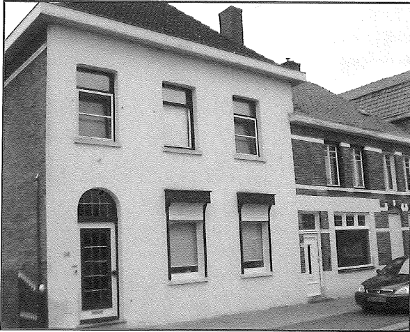
Afb. 2. Het huis van de familie Imandt in St. Jansteen. In de aangebouwde leslokalen zijn een winkel en een woonhuis gevestigd.
